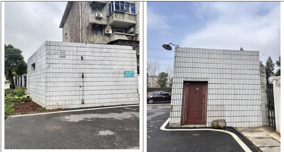
图 4 水文苑（锁石岭路）排涝泵站
