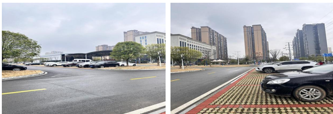
图 14 赤壁市政中心光充储一体化电站
