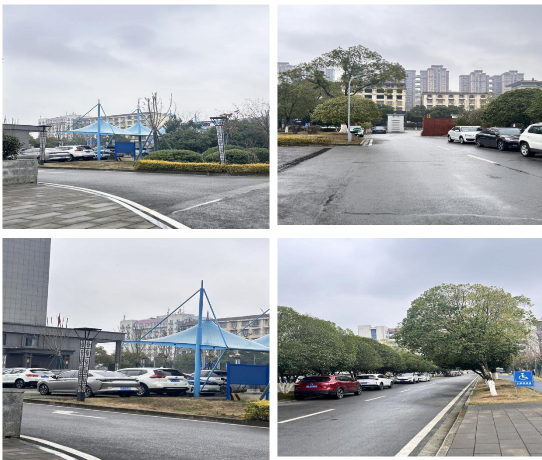
图 13 赤壁市人民政府光充储一体化电站
